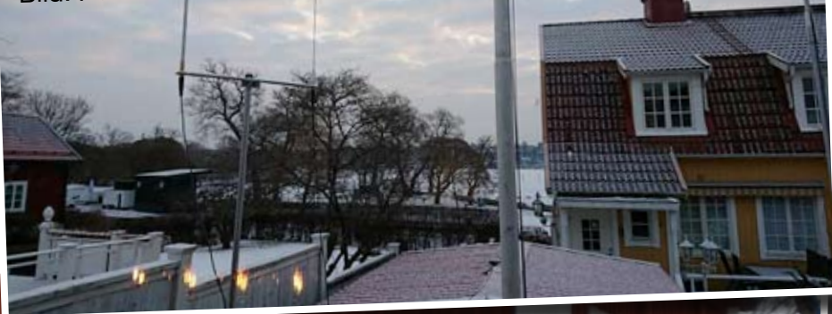
Sambandscentralen Sigtuna - antennbestyckning. Bild: Peter Wolf
